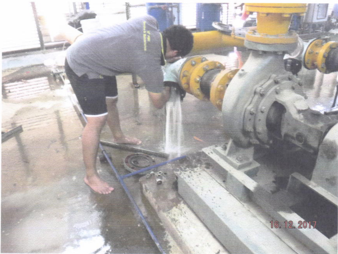
รูปที่ 16 แสดงการล้างทำความสะอาดตัวกรอง Strainer
