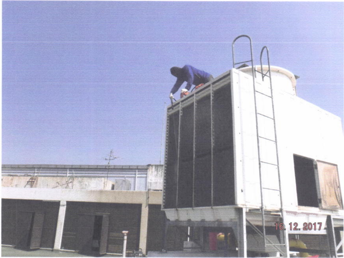
รูปที่ 11 แสดงการล้างทำความสะอาด Cooling tower
