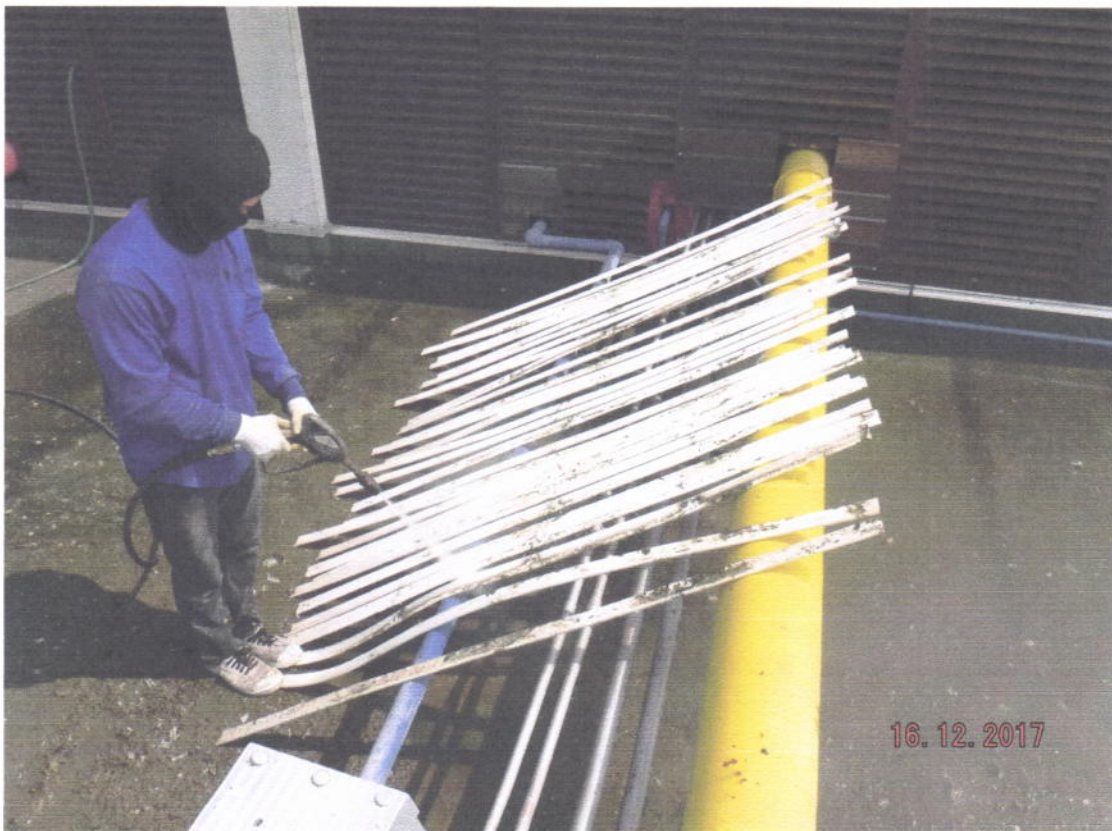
ภาพที่ 6 แสดงการล้างทำความสะอาด Cooling tower
