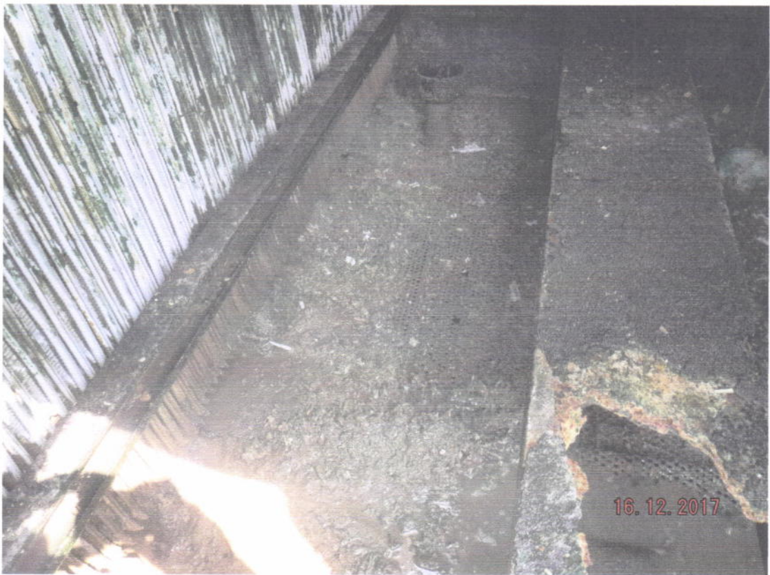
ภาพที่4 แสดงการล้างทำความสะอาด Cooling tower
