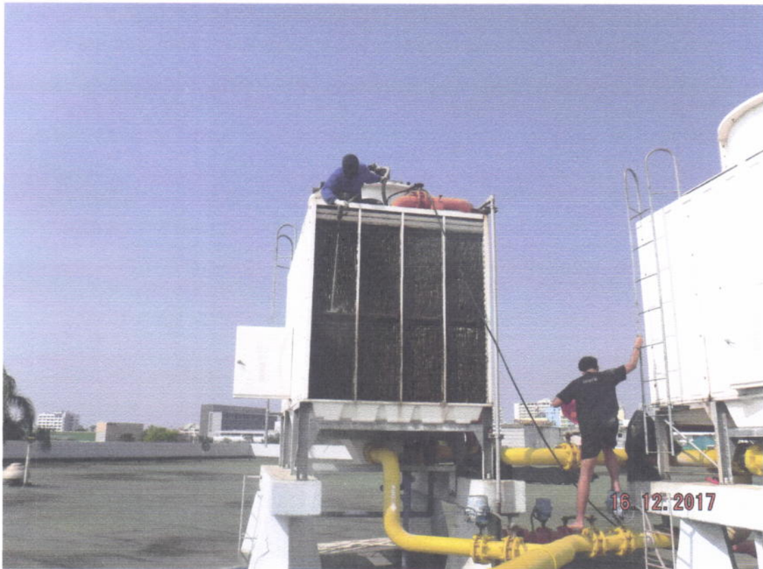
ที่10 แสดงการล้างทำความสะอาด Cooling tower
