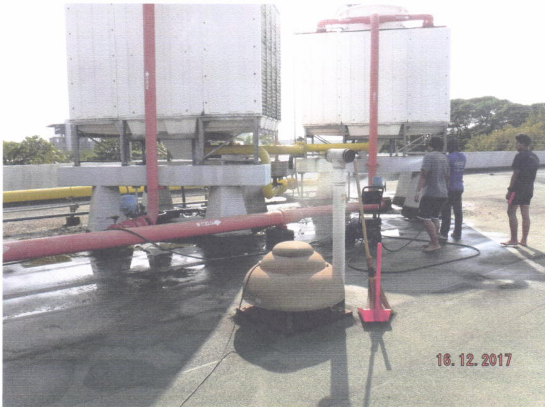
รูปที่ 12 แสดงการล้างทำความสะอาด พื้นที่รอบ Cooling tower
