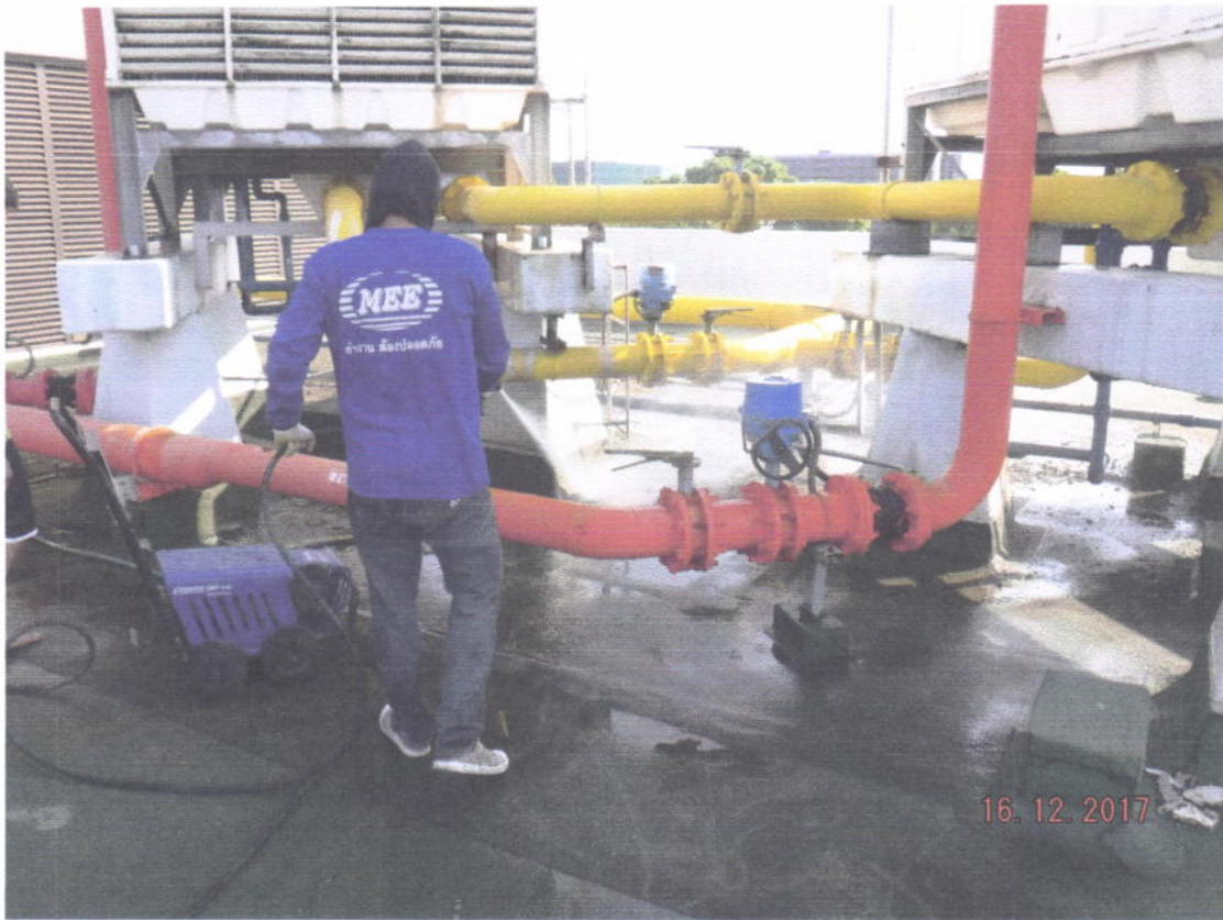
รูปที่ 13 แสดงการล้างทำความสะอาด พื้นที่รอบ Cooling tower
