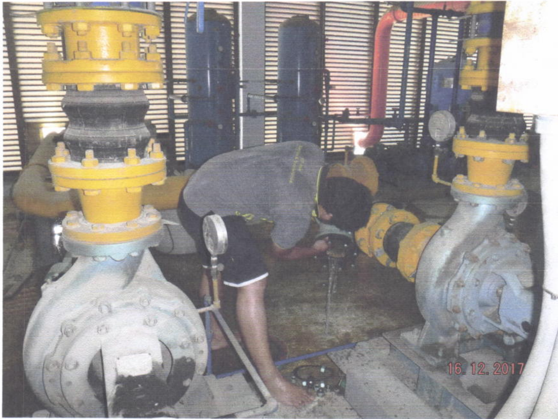
รูปที่ 15 แสดงการล้างทำความสะอาดตัวกรอง Strainer
