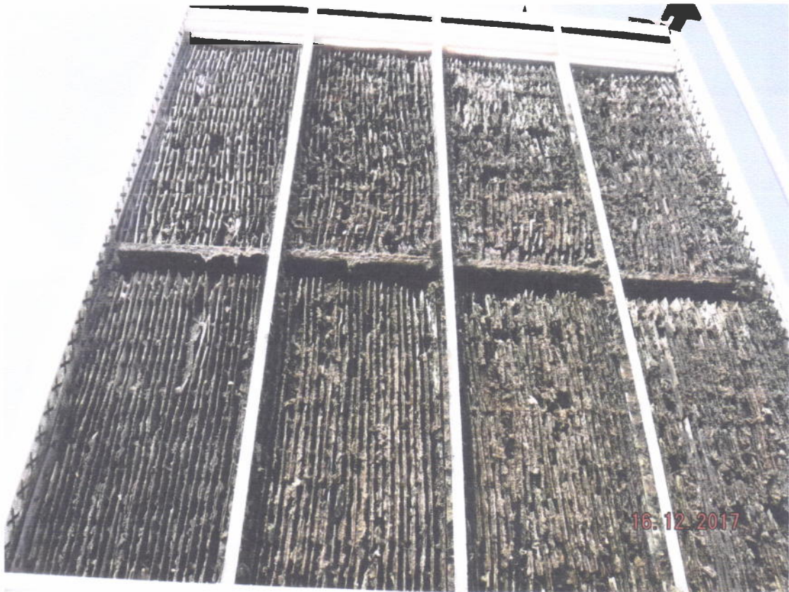
ภาพที่3 แสดงการล้างทำความสะอาด Cooling tower
