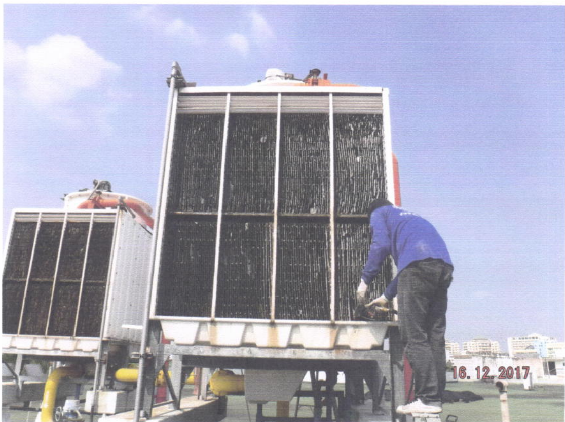
ภาพที่ 2 แสดงการล้างทำความสะอาด Cooling tower
