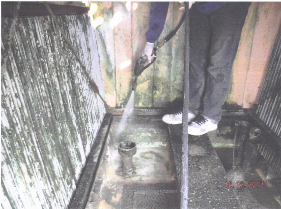
ภาพที่8 แสดงการล้างทำความสะอาด Cooling tower
