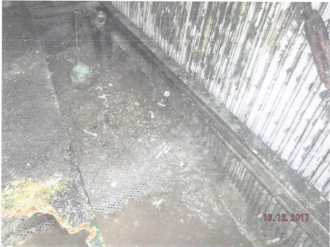
ภาพที่ 5 แสดงการล้างทำความสะอาด Cooling tower
