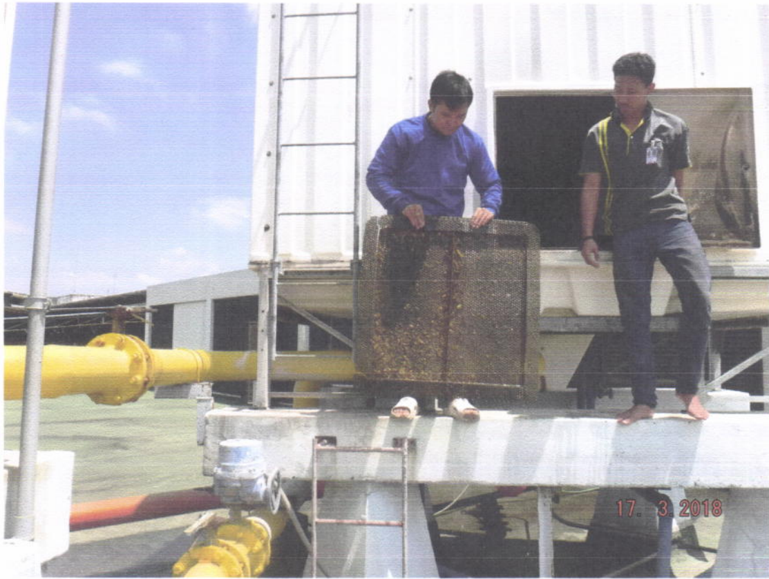
ภาพที่11 แสดงการทำความสะอาดกรองตะกอนในคูลิ่ง
