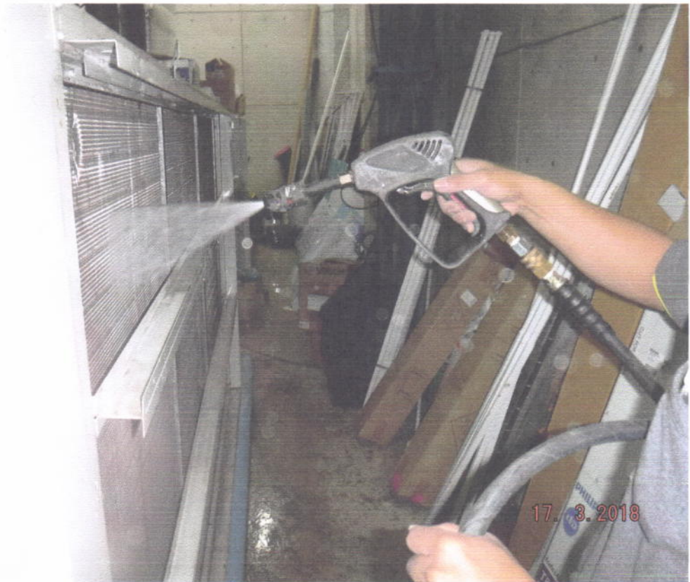
ภาพที่ 8 แสดงการฉีดล้างทำความสะอาด AHU
