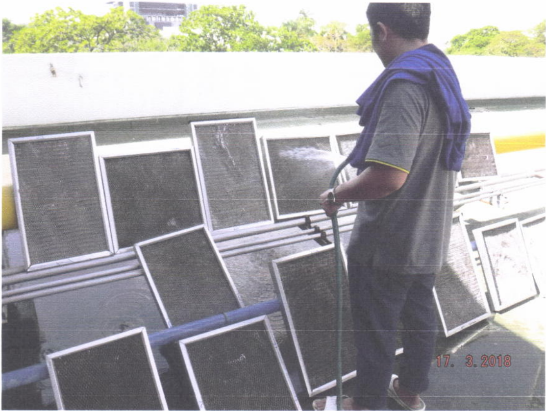
ภาพที่ 1 แสดงการนำแผ่นฟิลเตอร์ของเครื่องปรับอากาศมาล้างทำความสะอาด
