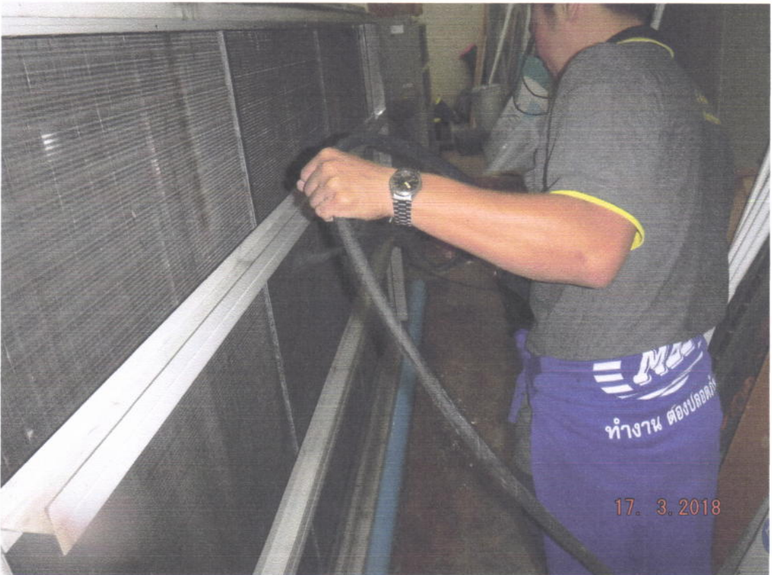
ภาพที่ 6 แสดงการฉีดล้างทำความสะอาด AHU
