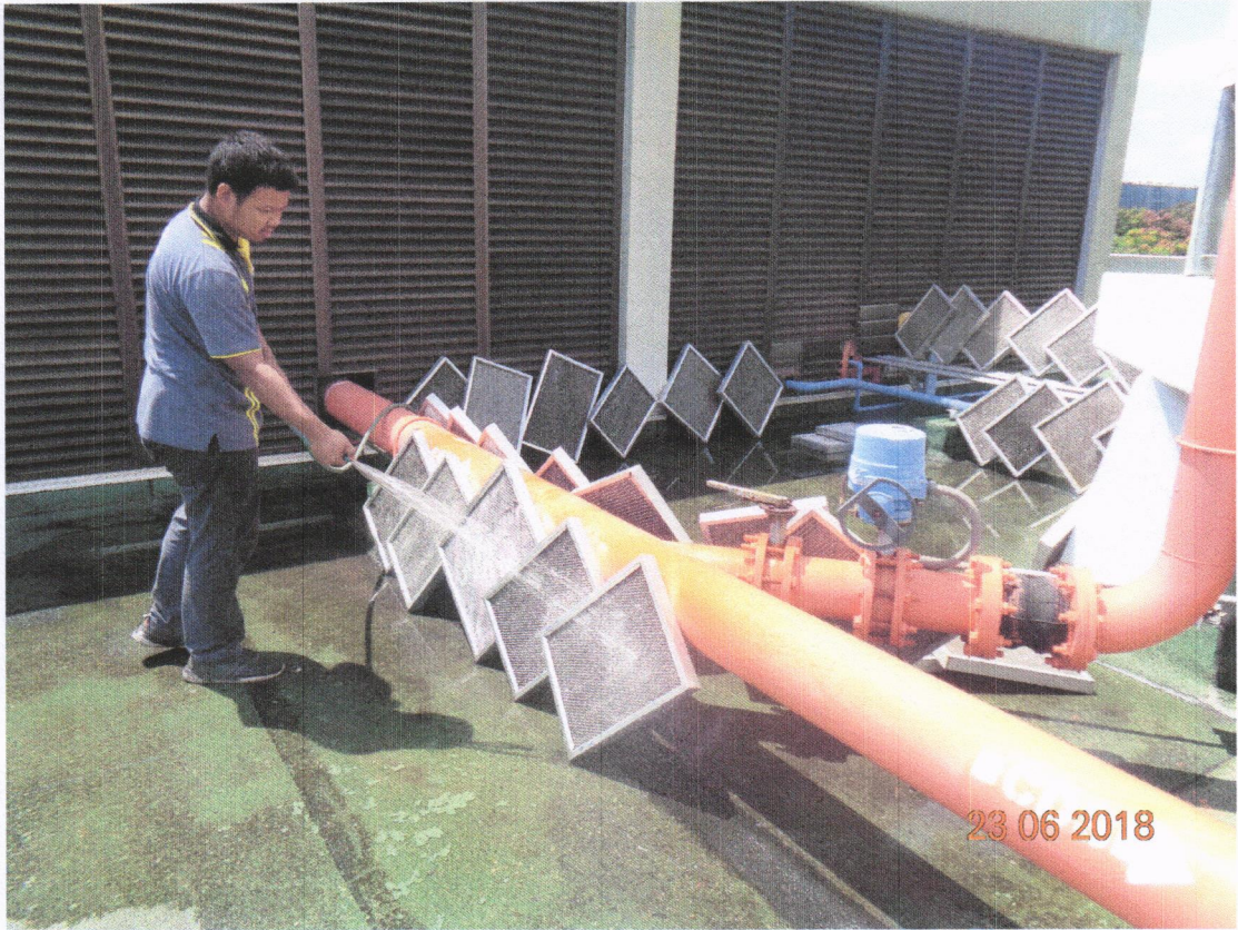
ภาพที่ 3 แสดงการนำแผ่นฟิลเตอร์ของเครื่องปรับอากาศมาล้างทำความสะอาด ชั้น 2
