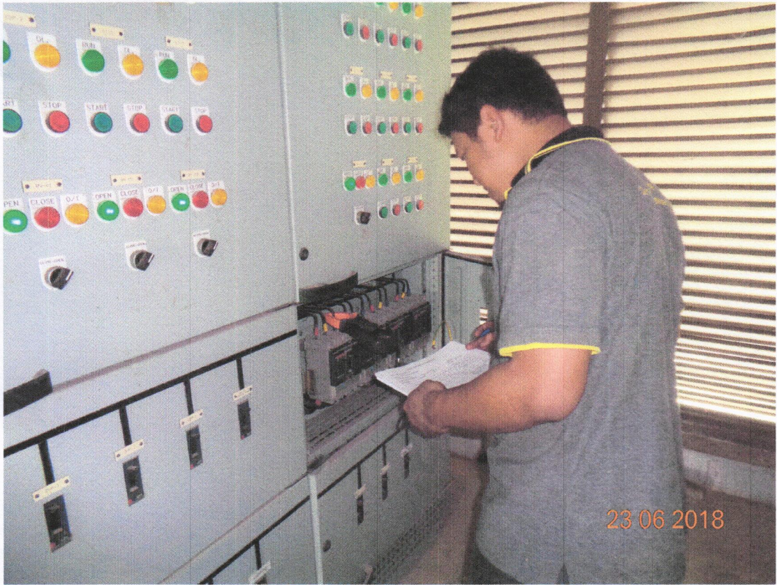
ภาพที่9 แสดงการจดบันทึกค่ากระแสของมอเตอร์
