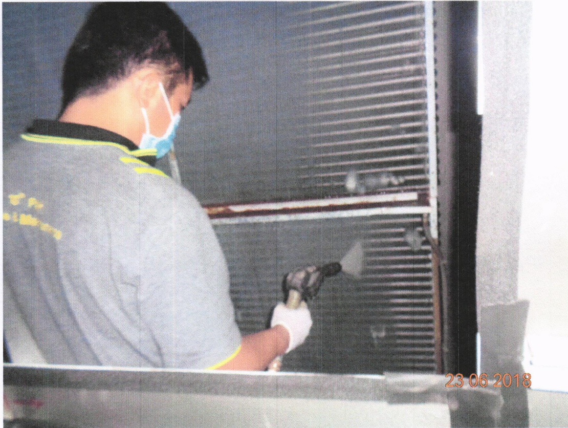
ภาพที่ 7 แสดงการฉีดล้างทำความสะอาด AHUชั้น 2
