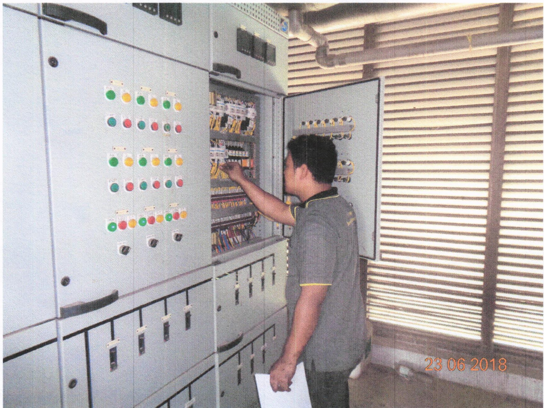
ภาพที่10 แสดงการจดบันทึกค่ากระแสของมอเตอร์
