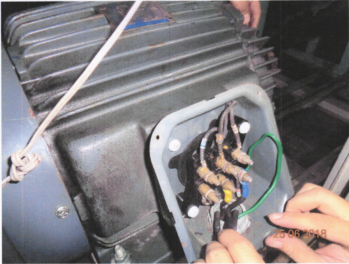
รูปที่ 15 นํามอเตอร์ ของ AHU -2B ที่นำไปซ่อมกลับมาติดตั้งให้ใช้งานได้ตามปกติ
