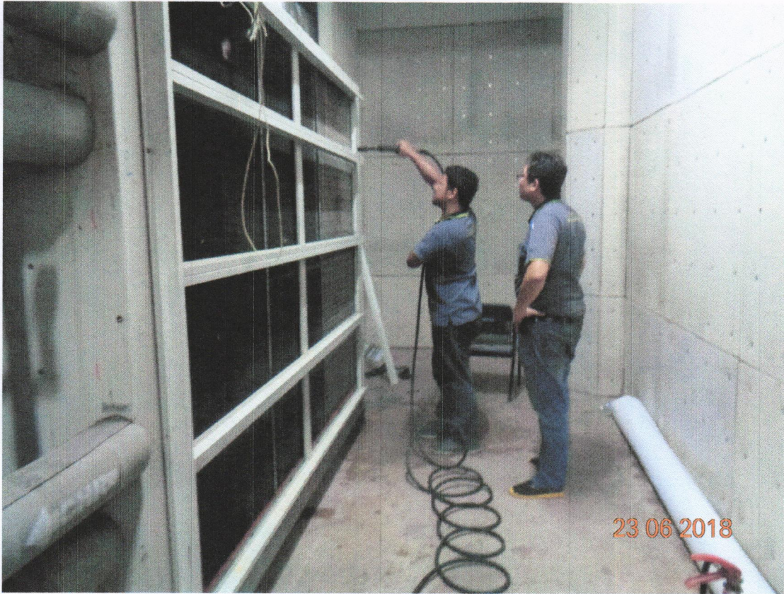
ภาพที่ 5 แสดงการฉีดล้างทำความสะอาด AHU ชั้น 2
