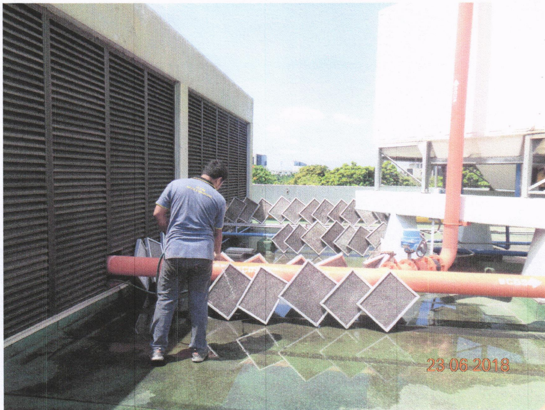
ภาพที่ 2 แสดงการนำแผ่นฟิลเตอร์ของเครื่องปรับอากาศมาล้างทำความสะอาด ชั้น 2
