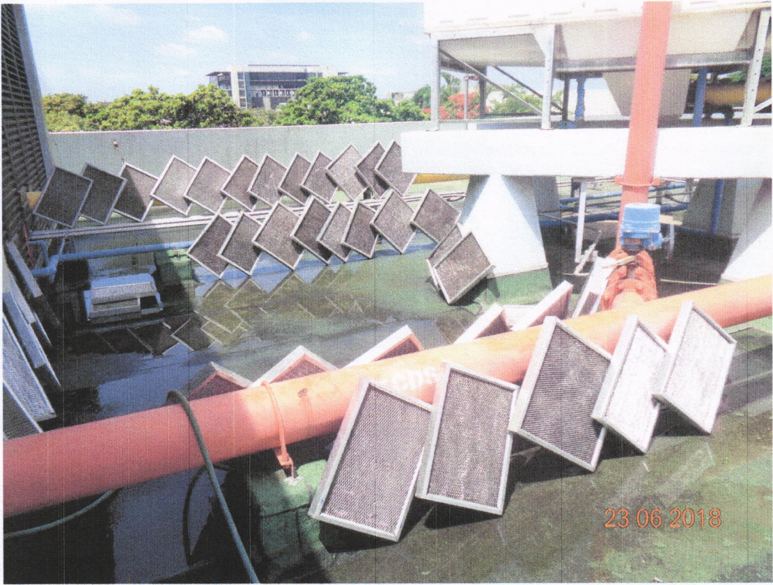
ภาพที่ 1 แสดงการนำแผ่นฟิลเตอร์ของเครื่องปรับอากาศมาล้างทำความสะอาด ชั้น 2
