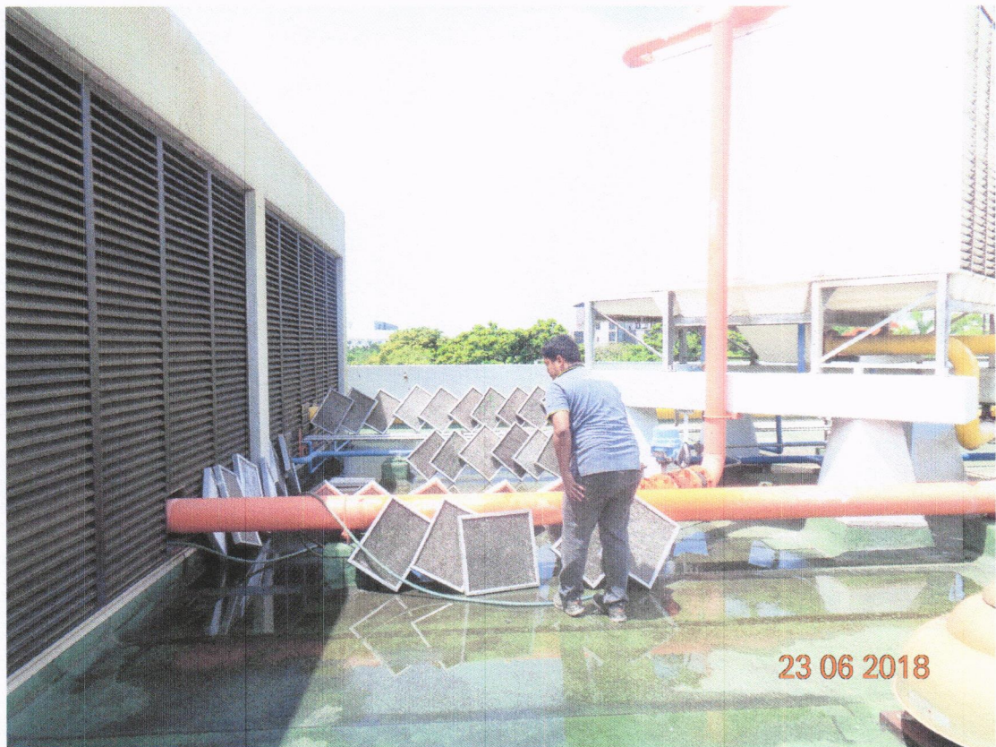
ภาพที่ 4 แสดงการนำแผ่นฟิลเตอร์ของเครื่องปรับอากาศมาล้างทำความสะอาด ชั้น 2
