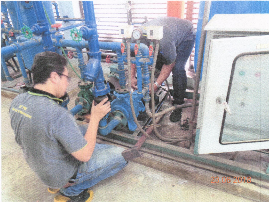
รูปที่ 11 นำ Booster pump ที่ซ่อมกลับมาติดตั้ง
