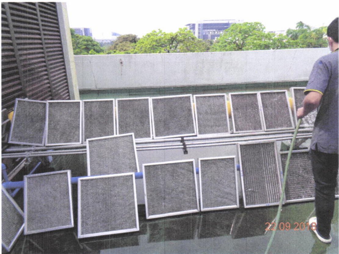
ภาพที่4 แสดงการนำแผ่นฟิลเตอร์ของเครื่องปรับอากาศมาล้างทำความสะอาด
