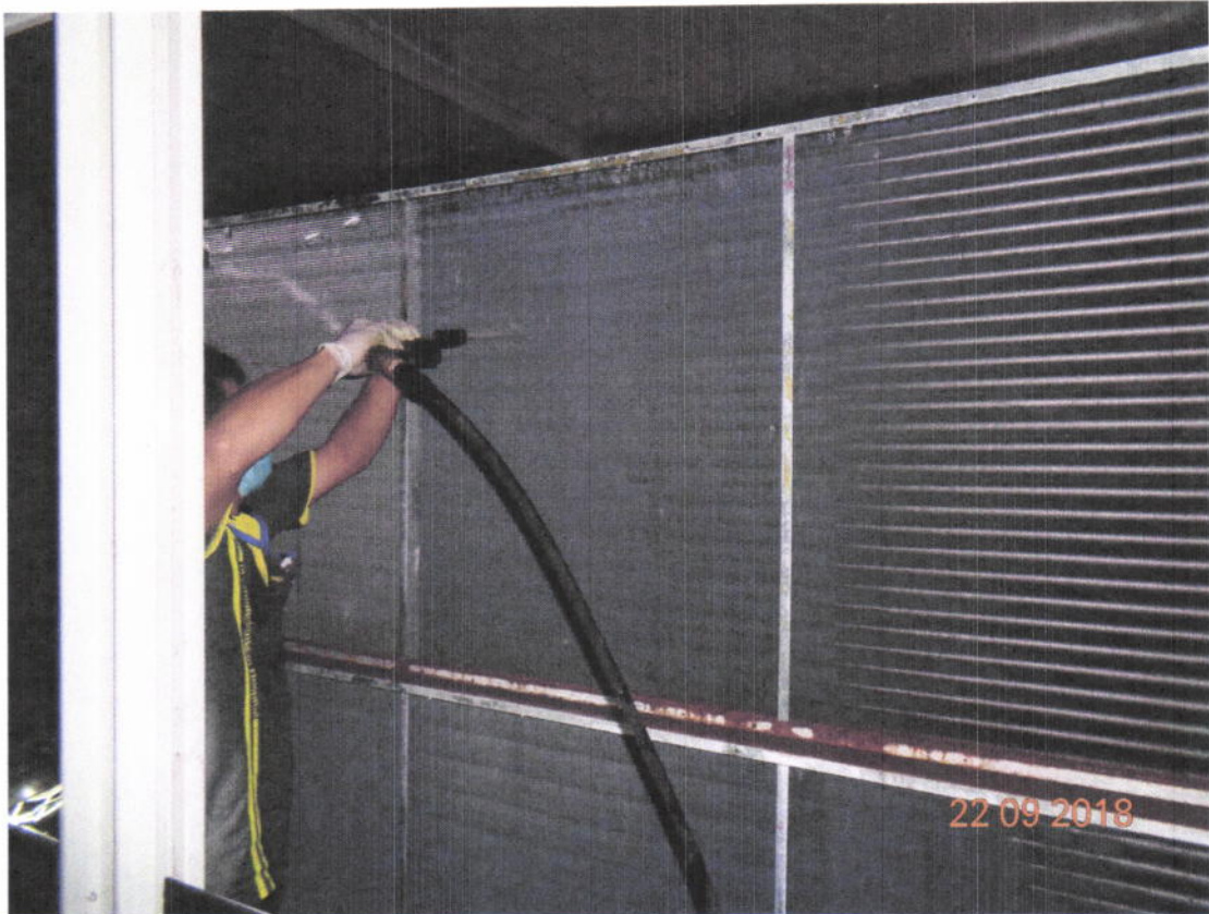
ภาพที่7 แสดงการล้างทำความสะอาดคอล์ยเย็น
