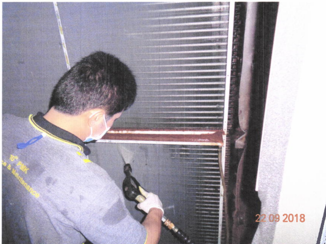
ภาพที่8 แสดงการล้างทำความสะอาดคอล์ยเย็น
