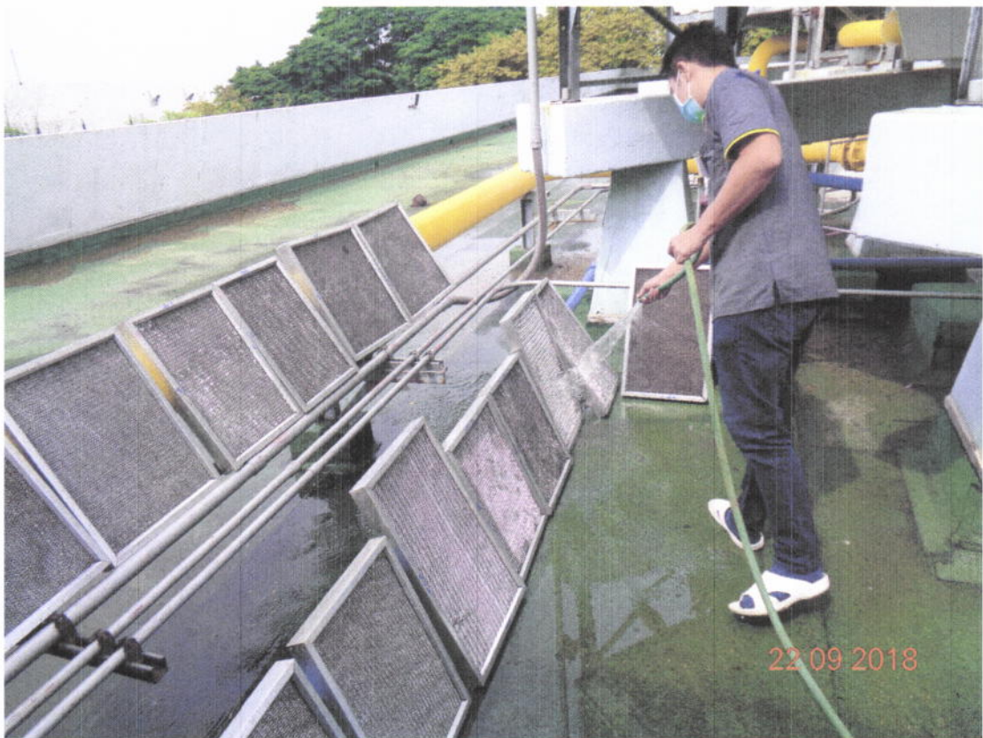
ภาพที่ 2 แสดงการนำแผ่นฟิลเตอร์ของเครื่องปรับอากาศมาล้างทำความสะอาด
