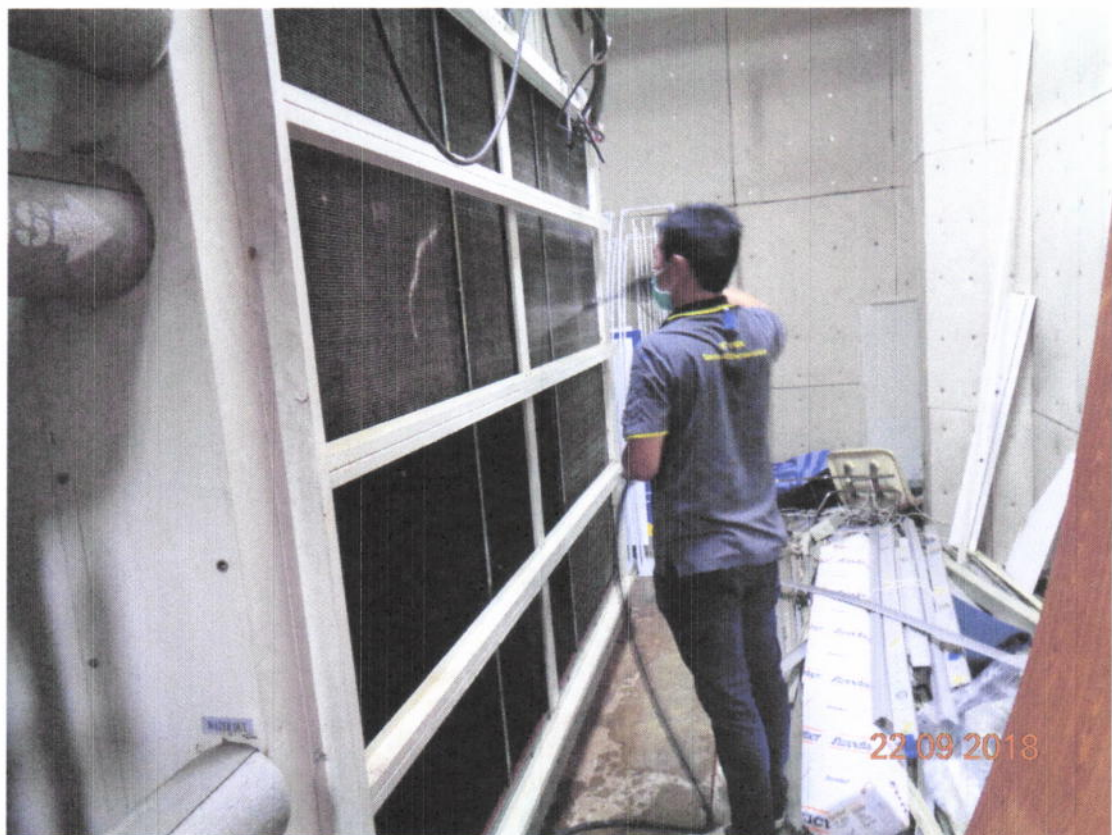
ภาพที่ 6 แสดงการล้างทำความสะอาดคอลย์เย็น
