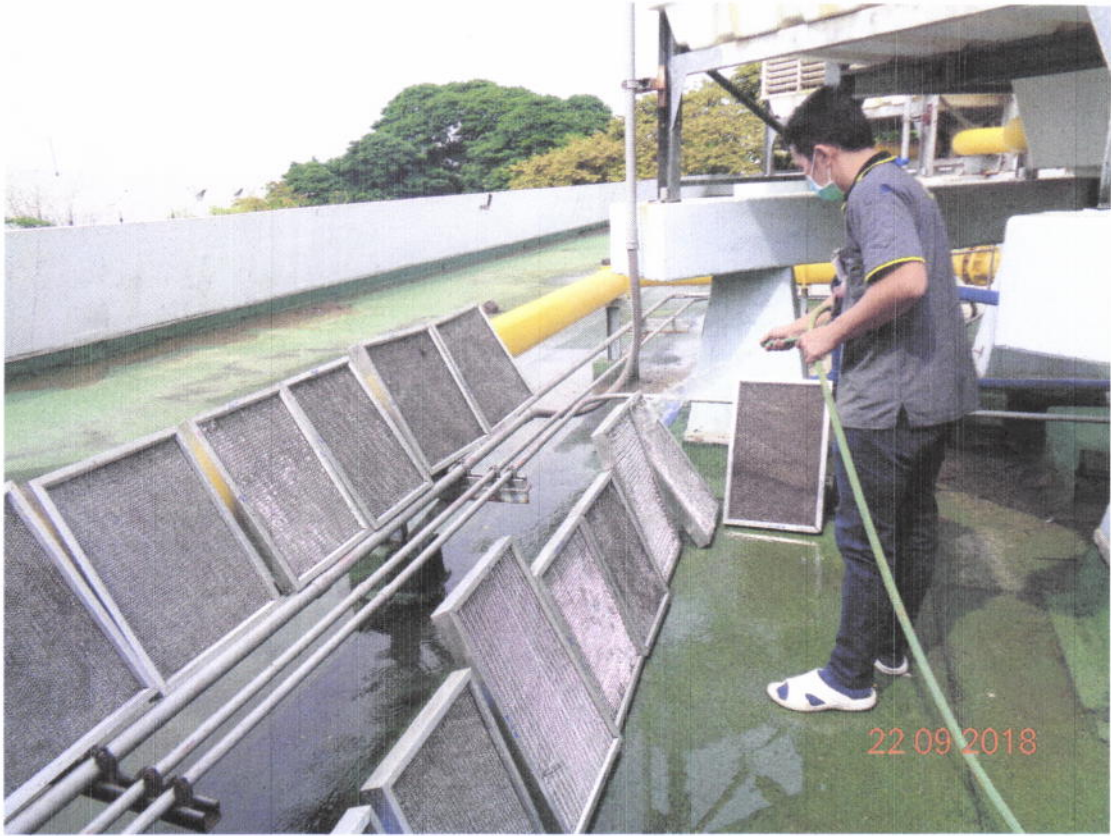
ภาพที่3 แสดงการนำแผ่นฟิลเตอร์ของเครื่องปรับอากาศมาล้างทำความสะอาด
