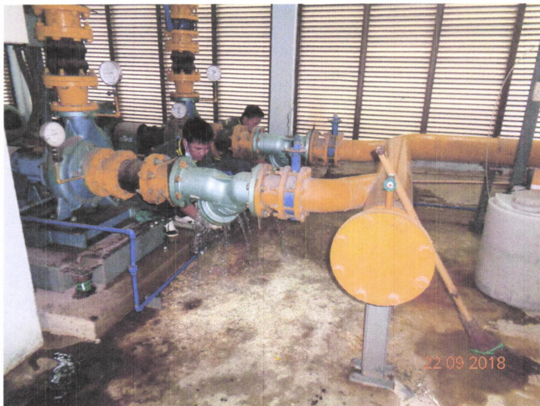
ที่10 แสดงการล้างทำความสะอาด Strainer
