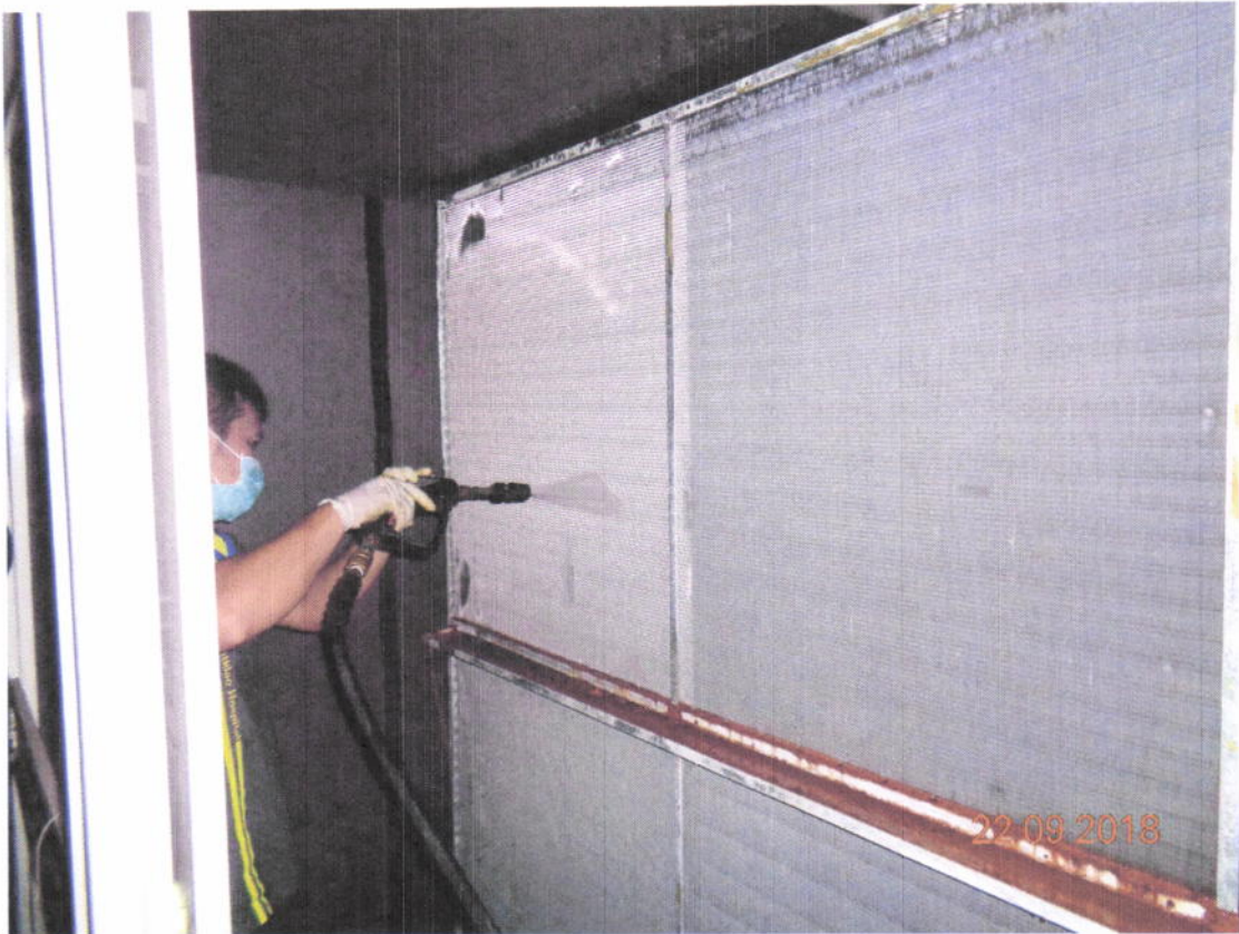
ภาพที่ 5 แสดงการล้างทำความสะอาดคอลย์เย็น
