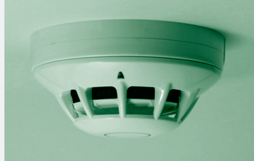
ภาพที่ 5 สัญญาณเตือนภัยแบบต่างๆ ได้แก่ Fire Alarm และ Smoke Detector ตามลำดับ
